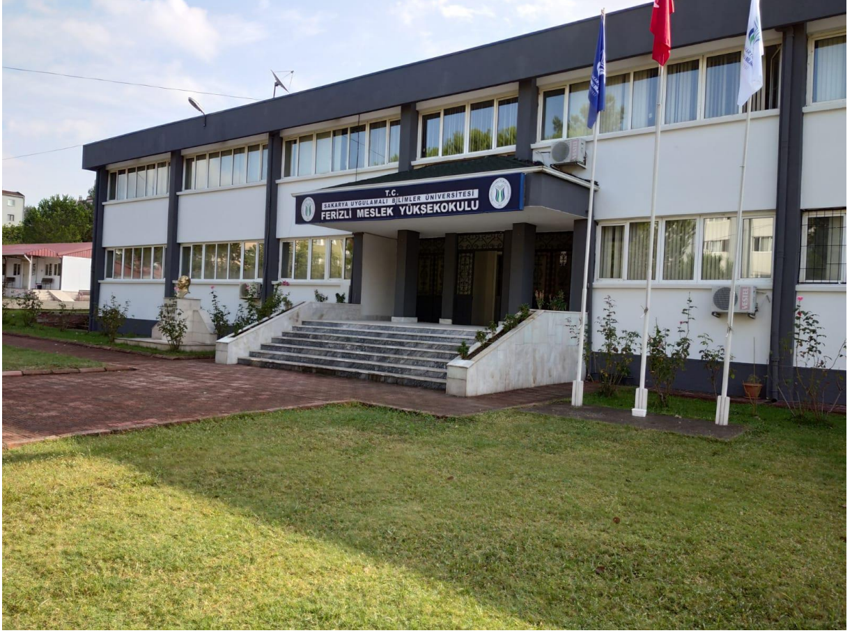
Ferizli Meslek Yüksekokulu Binası
